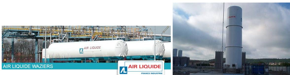
Figure 24. Éléments de stockage d'hydrogène liquide horizontaux et verticaux. (Source Air Liquide).
