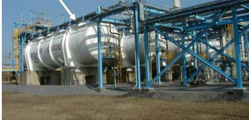
Figure 27. Stockage de LH<sub>2</sub> au sein de l'usine de liquéfaction de Waziers.
