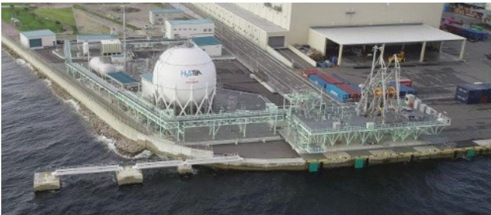
Figure 36. Terminal de réception de LH<sub>2</sub> KHI à Kobe [76].
