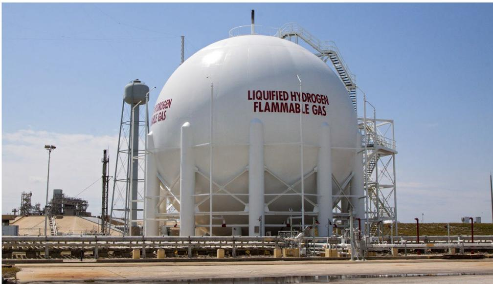
Figure 26. Réservoir de stockage de LH<sub>2</sub> d'une capacité de 3 800 m<sup>3</sup> au Centre spatial Kennedy, en Floride (source : NASA).
