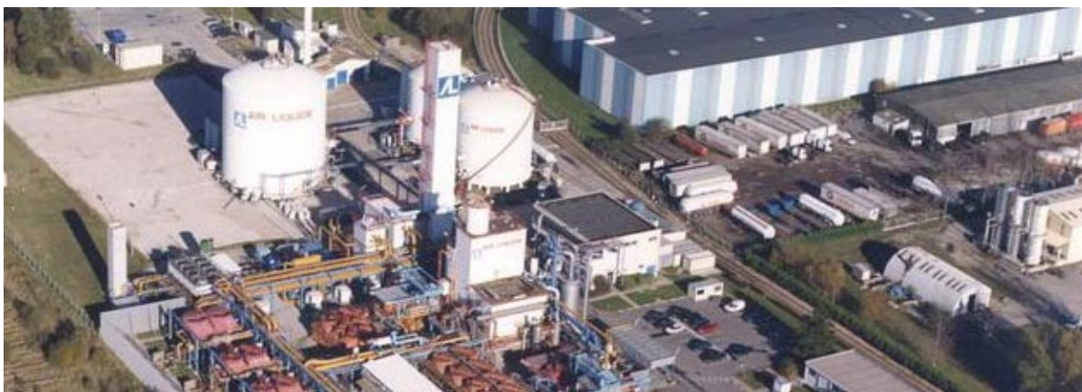
Figure 7. Installation de reformage à la vapeur AirLiquide [1]
