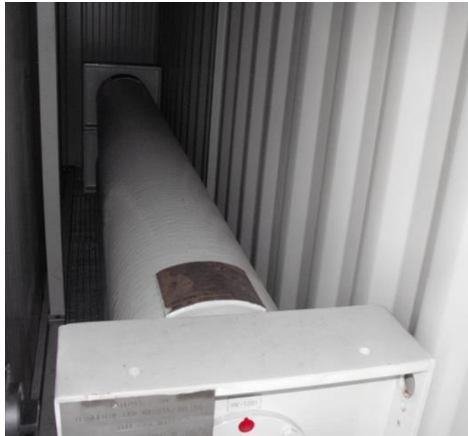
Figure 39 : Station-service à cuve haute pression 1 000 bar
