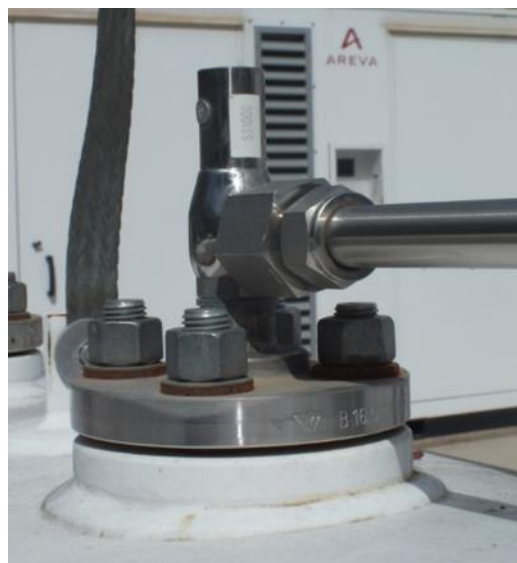
Figure 68 : Système de secours Areva (détail du dispositif de décompression) ©AREVA/ENSOSP 2015
