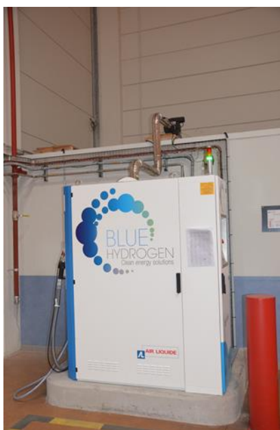
Figure 37: Station-service en intérieur pour chariot élevateur (distributeur)
