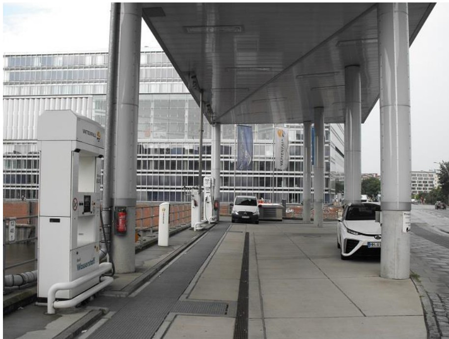
Figure 33: Station-service (Vattenfall Hambourg)
