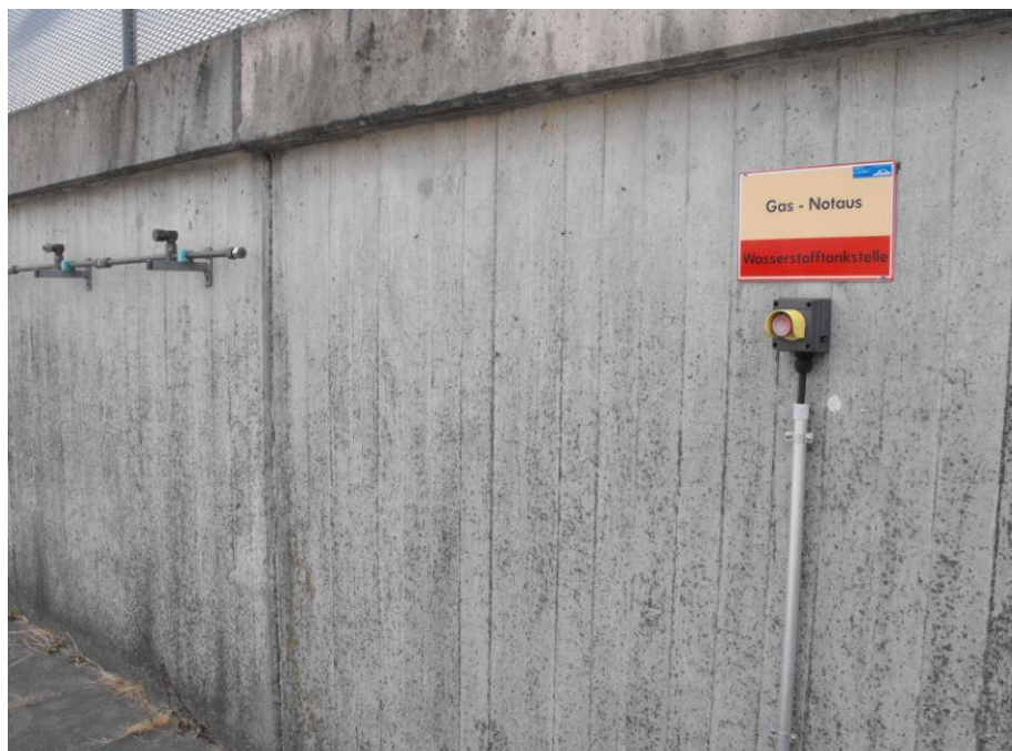
Figure 40 : Dispositif d'arrêt d'urgence de station-service éloigné du distributeur (aéroport de Hambourg)
