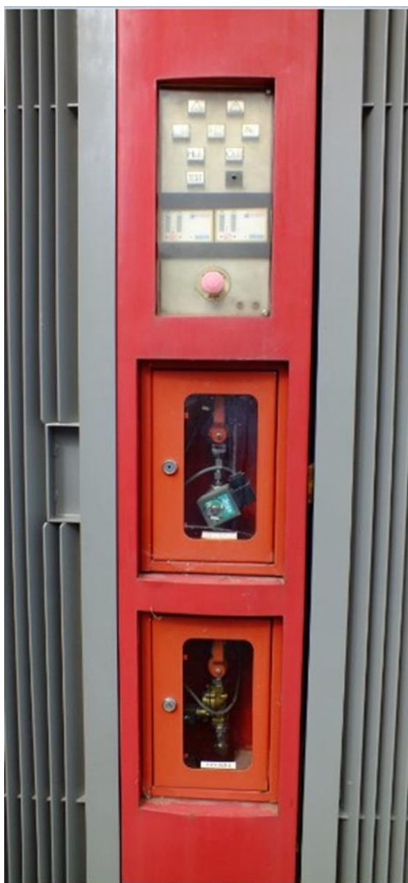
Figure 70 : Dispositif d'arrêt d'urgence et vannes H 2 /O 2 sur la Greenenergy Box d'AREVA ©AREVA/ENSOSP 2015
