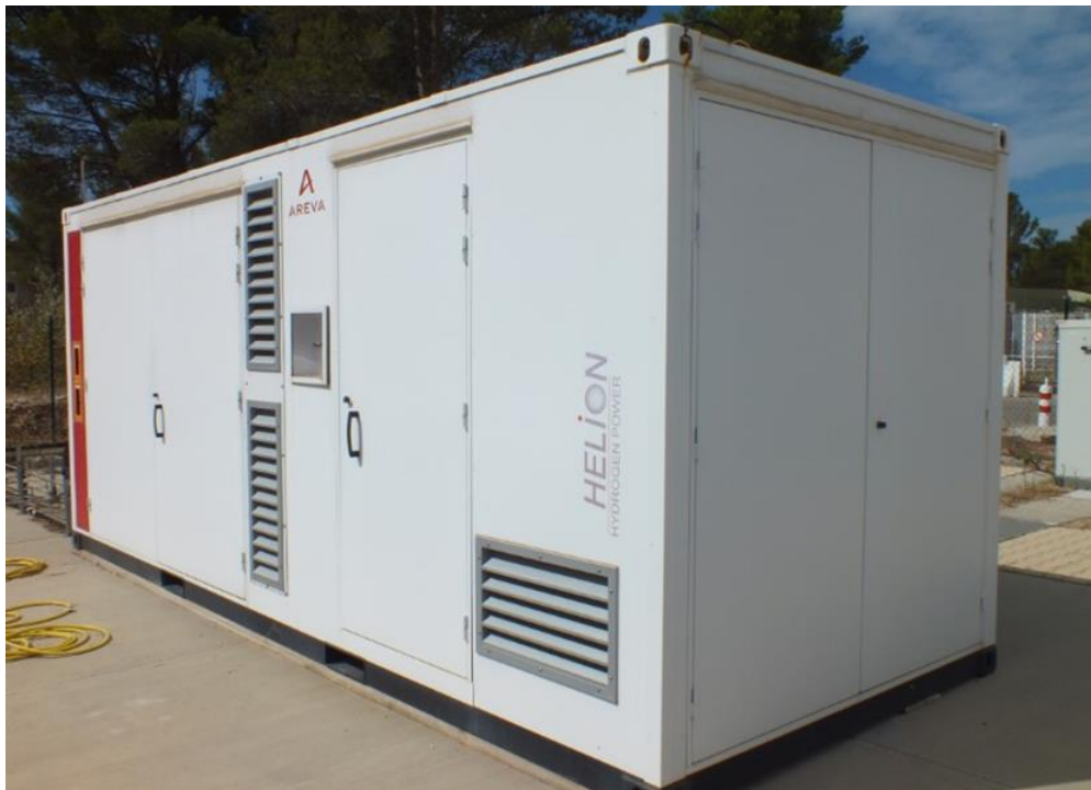
Figure 65 : Système de secours Areva (compartiment de la pile à combustible) ©AREVA/ENSOSP 2015
