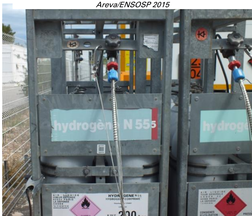
Figure 58 : Vannes sur un porte-bouteilles de H2 © Areva/ENSOSP 2015
