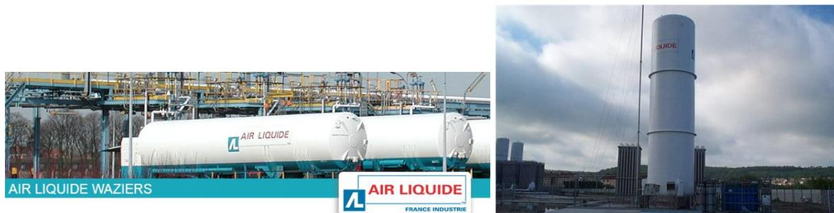
Figura 5. Serbatoi di idrogeno liquido verticali od orizzontali (Fonte Air Liquide).
