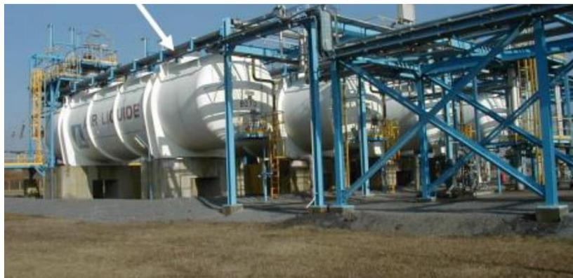
Figura 7. Serbatoi LH<sub>2</sub> nell'impianto di liquefazione di Waziers.
