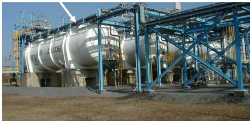
Abbildung 27. LH<sub>2</sub>-Lager in der Verflüssigungsanlage von Waziers.
