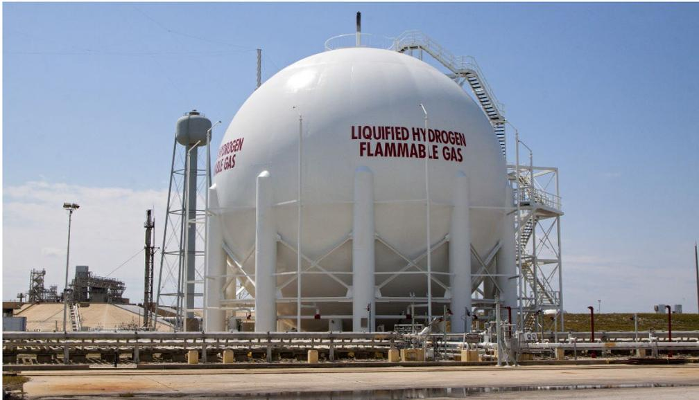
Abbildung 26. LH<sub>2</sub>-Lagerbehälter mit 3800 m<sup>3</sup> Fassungsvermögen am KSC in Florida (Quelle: NASA).
