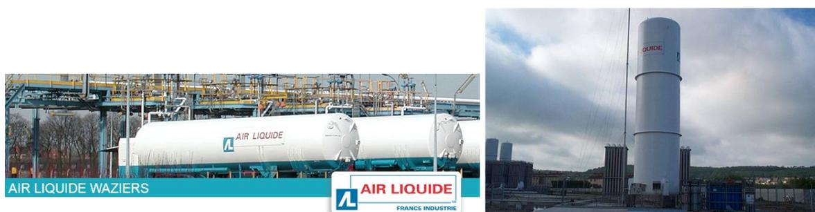
Abbildung 24. Horizontale und vertikale Flüssigwasserstoffspeicher. (Quelle: Air Liquide).
