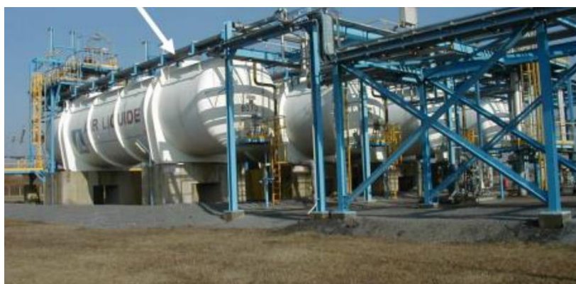
Obrázek 7 Zásobníky \text{LH}_2 v závodě na zkapalňování plynu společnosti Waziers.
