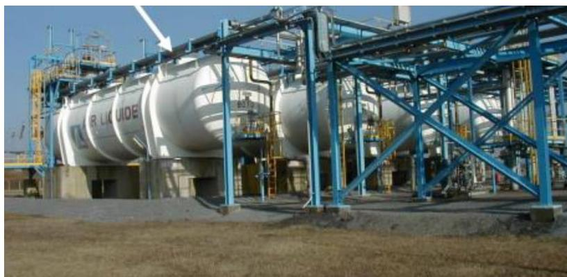
Abbildung 7 LH<sub>2</sub>-Lager in der Verflüssigungsanlage Waziers.
