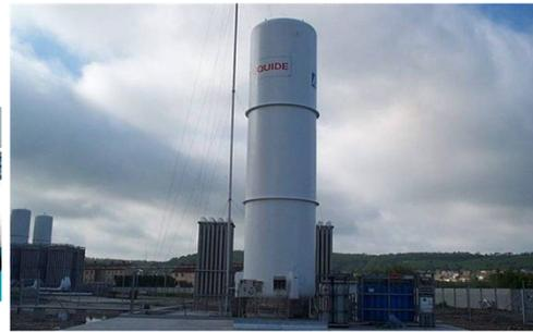
Abbildung 5. Horizontale und vertikale Flüssigwasserstoffspeicher. (Quelle: Air Liquide).
