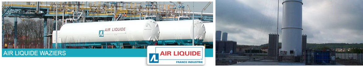
Figur 3. Horisontale og vertikale flytende hydrogen-lagre. (Kilde Air Liquide).
