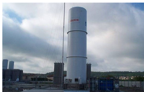
Obrázek 3. Horizontální a vertikální zásobníky kapalného vodíku. (Zdroj Air Liquide).
