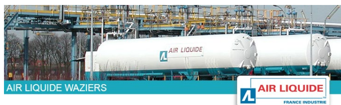
Obrázek 3. Horizontální a vertikální zásobníky kapalného vodíku. (Zdroj Air Liquide).
