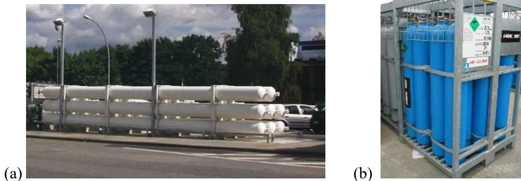
Figura 4. Esempi di contenitori per lo stoccaggio dell'idrogeno in applicazioni stazionarie: (a) gruppo fisso di cilindri, (b) stock di cilindri.
