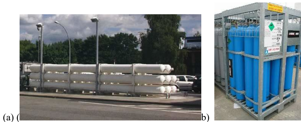
Abbildung 4. Beispiele für Wasserstoffspeicher, die für stationäre Anwendungen üblich sind: (a) ein festes Flaschenbündel, (b) ein Flaschenkorb.
