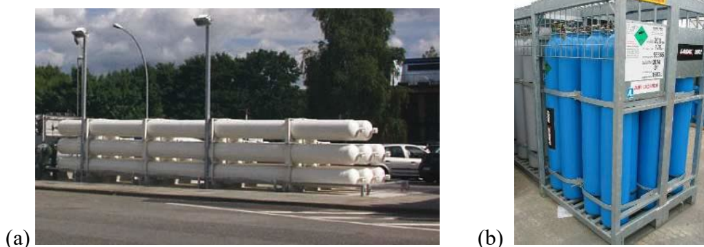
Obrázek 4. Příklady zásobníků vodíku obvyklých ve stacionárních aplikacích: (a) pevný svazek lahví, (b) koš lahví.
