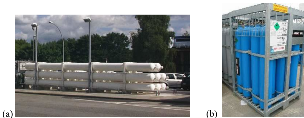
Obrázek 4. Příklady zásobníků vodíku obvyklých ve stacionárních aplikacích: (a) pevný svazek lahví, (b) koš lahví.
