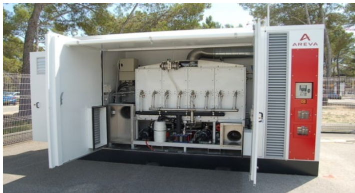
Obrázek 25. UPS s vodíkovými palivovými články ve spojení s datovým centrem IP Energy.
