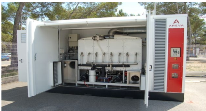
Figur 18. Et brenselcelle-nødstrømaggregat kombinert med IP Energy datasenter.
