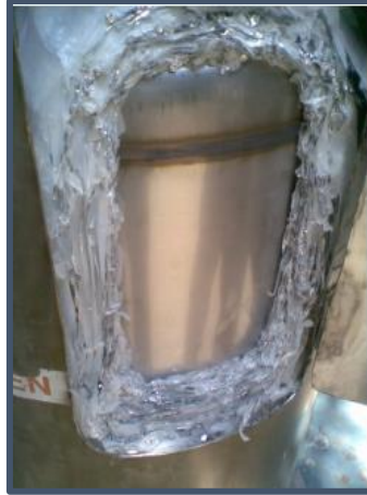
Figura 16. Isolamento MLI.
