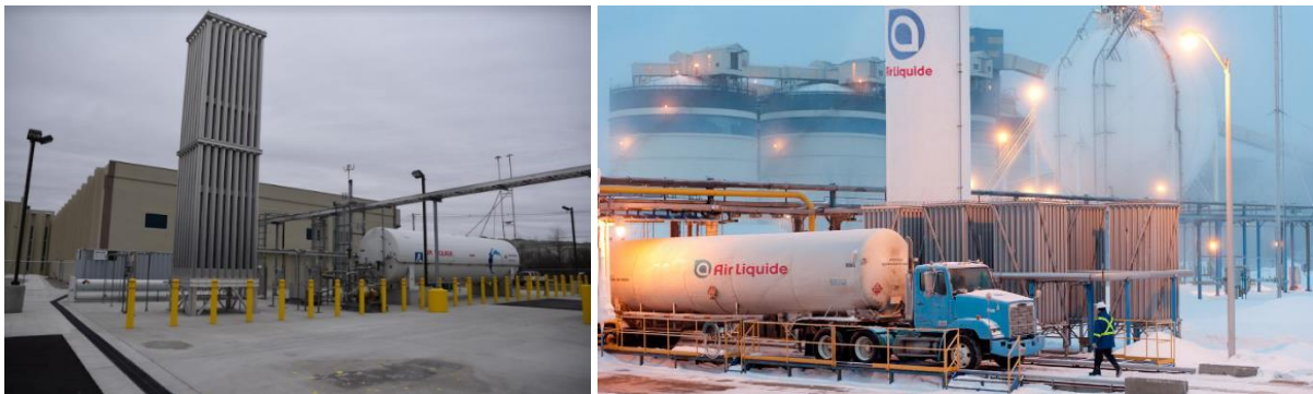
Figura 36. Stazione di rifornimento LH_2 Air Liquide (sinistra: Little Town, USA; destra: Becancour, Canada).
