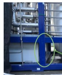
Abbildung 17. Aufprallschutz (in blau) am Boden.
