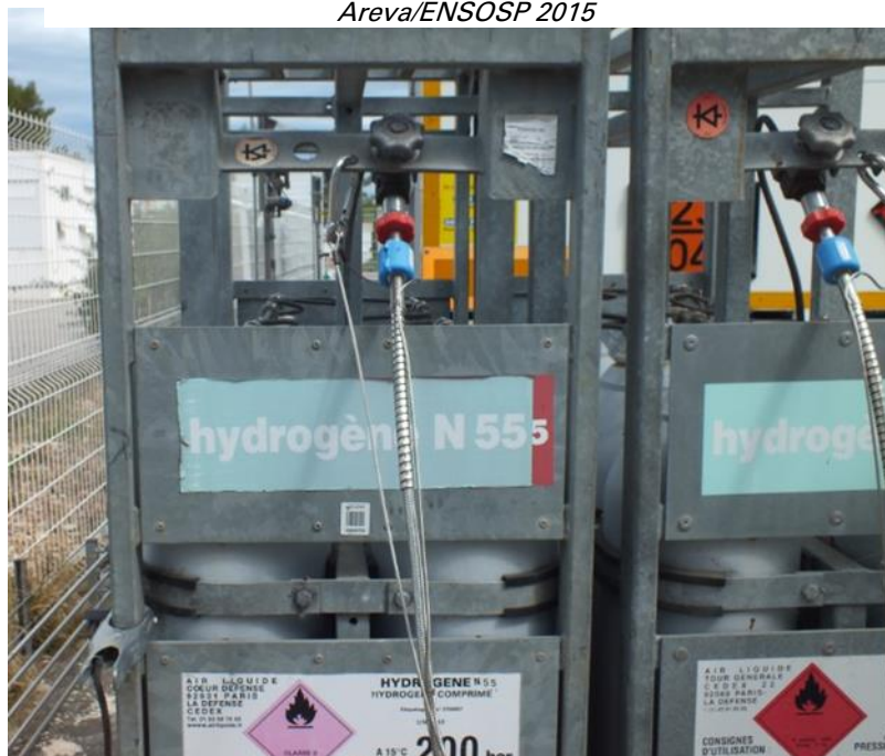
Figura 58: Valvole su bottiglie H2 in un Rack. © Areva/ENSOSP 2015
