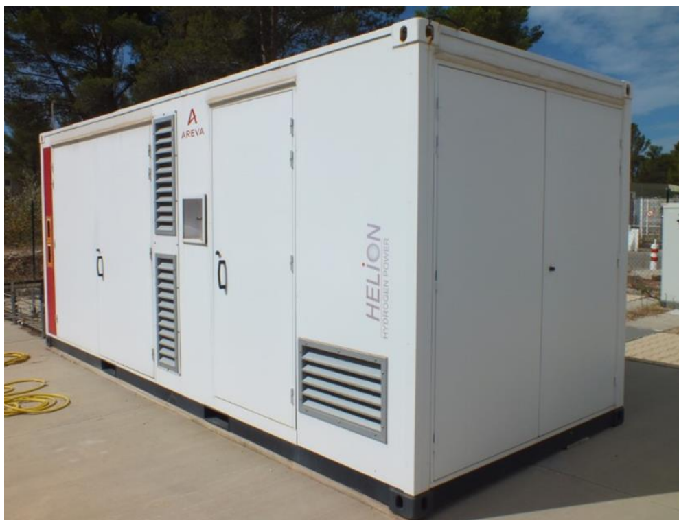
Figura 65: Sistema di backup Areva (container fuel cell). ©AREVA/ENSOSP 2015
