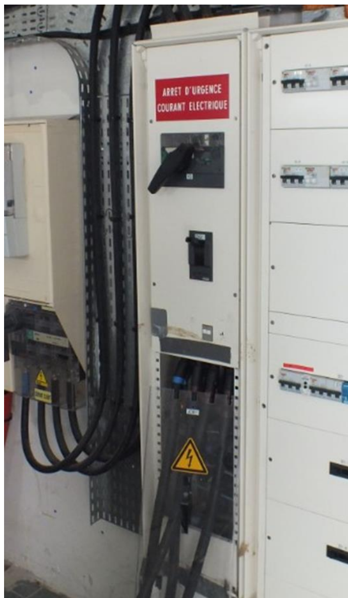
Obrázek 59 : Hlavní nouzový vypínač elektřiny © Areva/ENSOSP 2015
