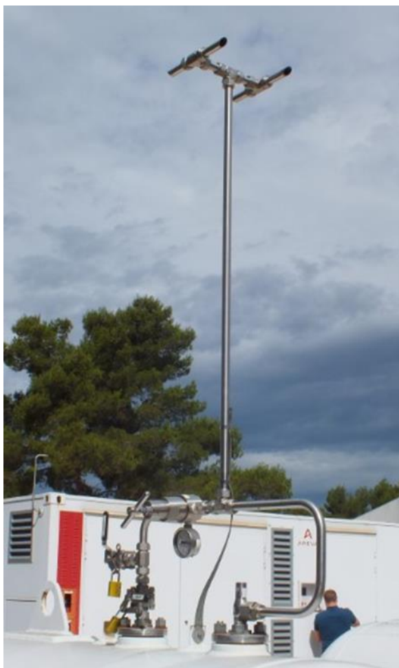
Obrázek 67: Záložní systém Areva (zařízení pro uvolnění přetlaku) ©AREVA/ENSOSP 2015
