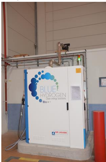
Obrázek 36: Výdejní stojan 350 bar (Vattenfall Hamburk)
