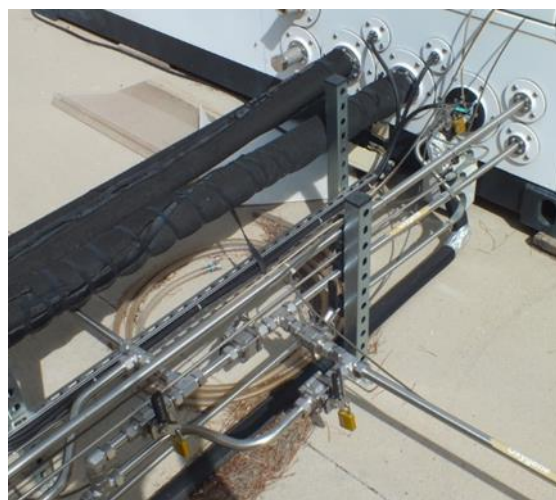
Obrázek 69: Obrázek 35 Záložní systém Areva (detail sítě H2 a O2 s ventily) ©AREVA/ENSOSP 2015
