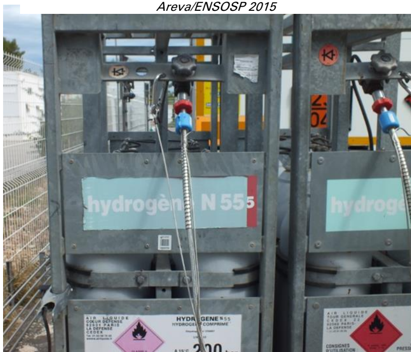
Obrázek 58: Ventily na stojanu na láhve s H2 © Areva/ENSOSP 2015
