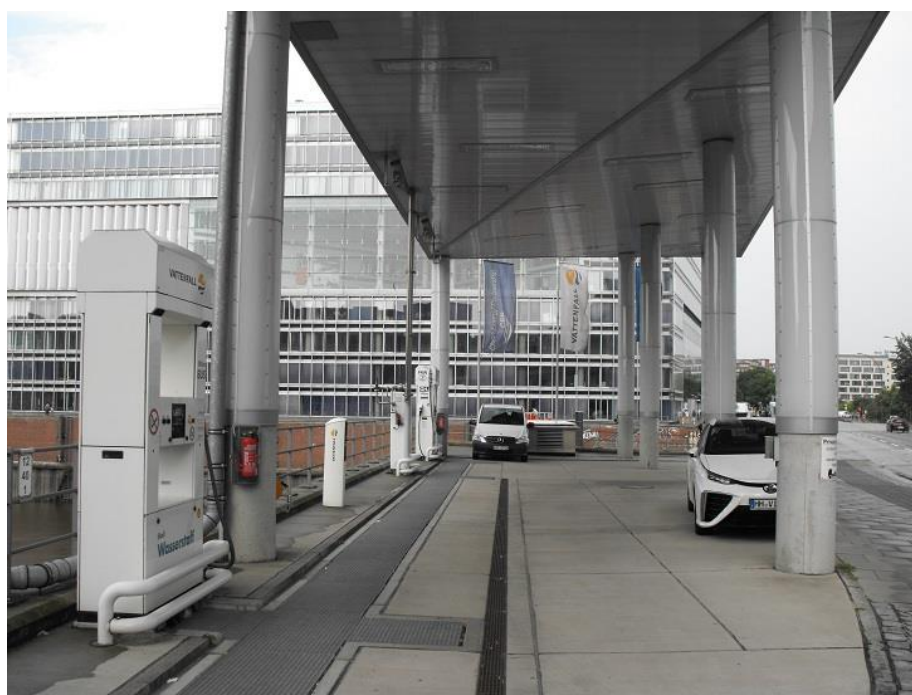
Obrázek 33: Čerpací stanice (Wattfall Hamburg)
