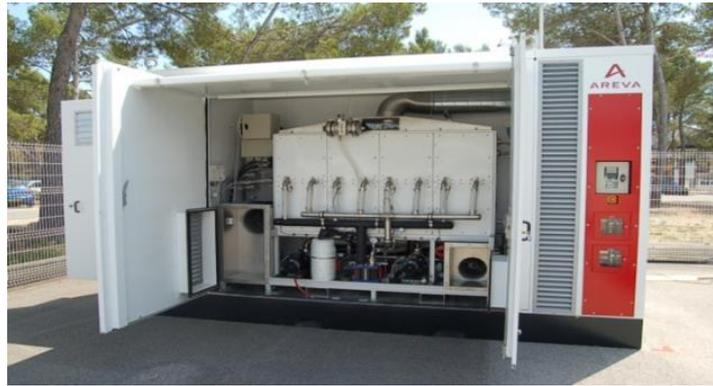
Figure 19 Une alimentation de secours par pile à combustible couplée à un centre de données IP Energy
