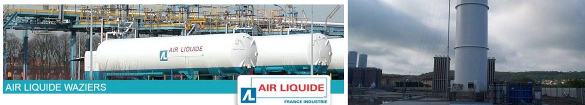
Figuur 3. Horizontale en verticale opslagsystemen voor vloeibare waterstof. (Bron: Air Liquide).
