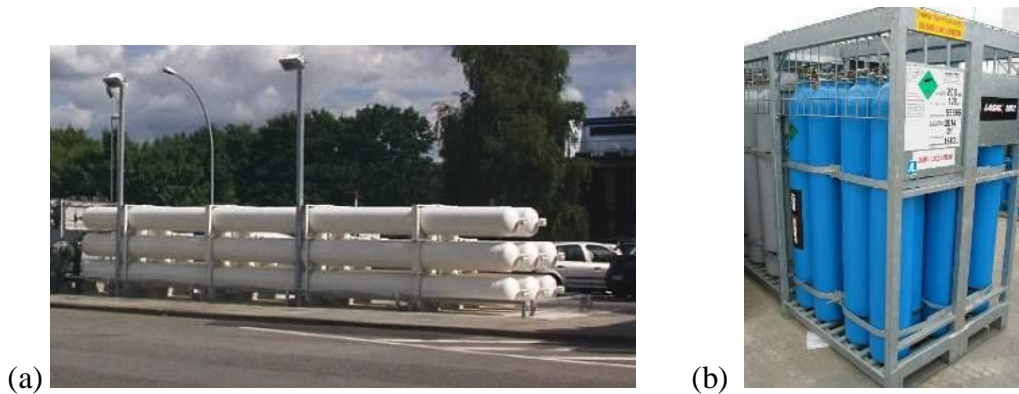
Figuur 4. Voorbeelden van opslagvaten voor waterstof die gangbaar zijn bij stationaire toepassingen:
