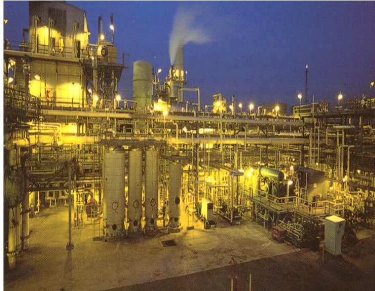
Figuur 30. Installatie voor omzetting van methaan met stoom van Air Liquide.
