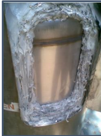
Figuur 16. Meerlaagse isolatie.
