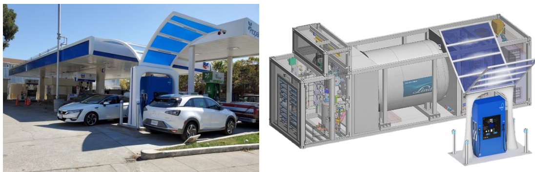
Figuur 5. Tankstation voor vloeibare waterstof van Linde in Oakland.
